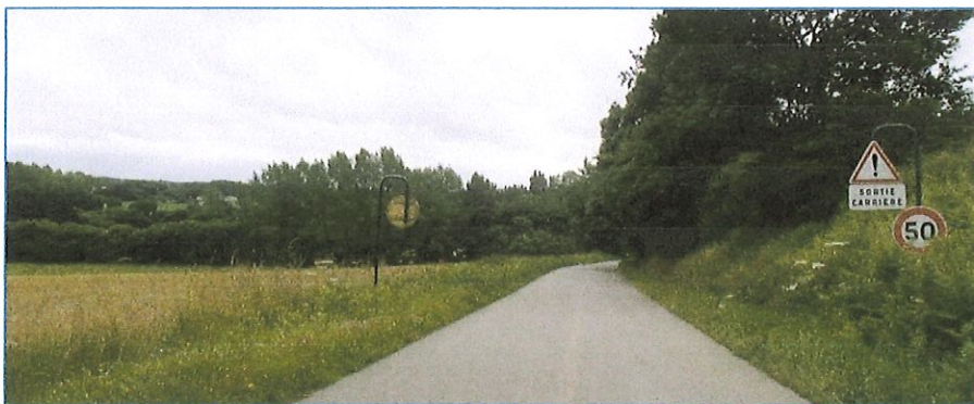
Vue sur la signalisation sur la VC n°2 en venant d'Hénanbihen
